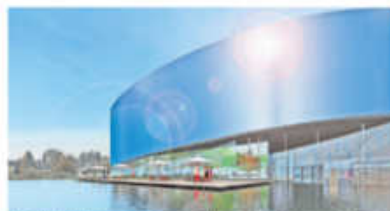
LAC ARTIFICIEL Le complexe Aquaparc aura sa petite plénitude d'eau, avec une vue plongeante sur le Léman. Outre les aquariums géants accompagnés de leur espace de jeu, l'ensemble abritera un hôtel de 117 chambres et les 1200 places du parking-relais de Vennes.
