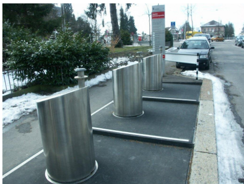
Unterflursammelstelle in Bern
