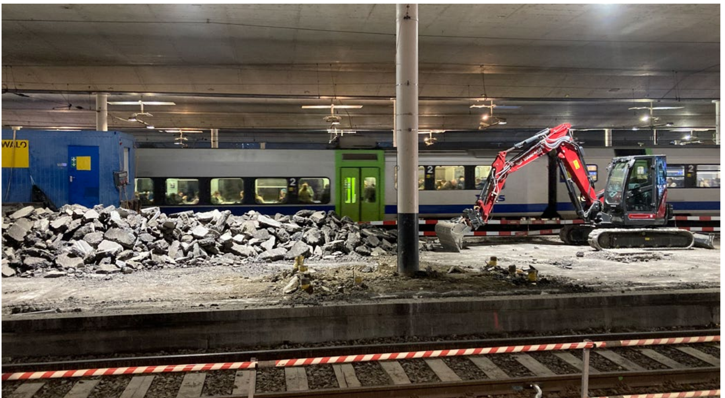
In molti luoghi sono in corso i lavori di costruzione volti all'adeguamento ai requisiti della BehiG. Spesso tali lavori vengono combinati con altri interventi edilizi. © UFT
