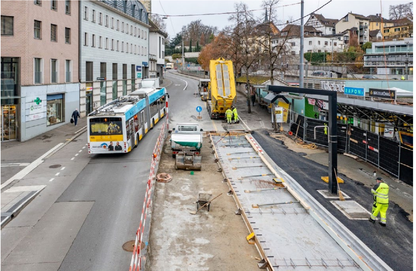
Costruzione di un bordo di fermata degli autobus conforme alla LDis nella piazza della stazione di Sciaffusa (© michael.schmid.photo, Città Sciaffusa)
