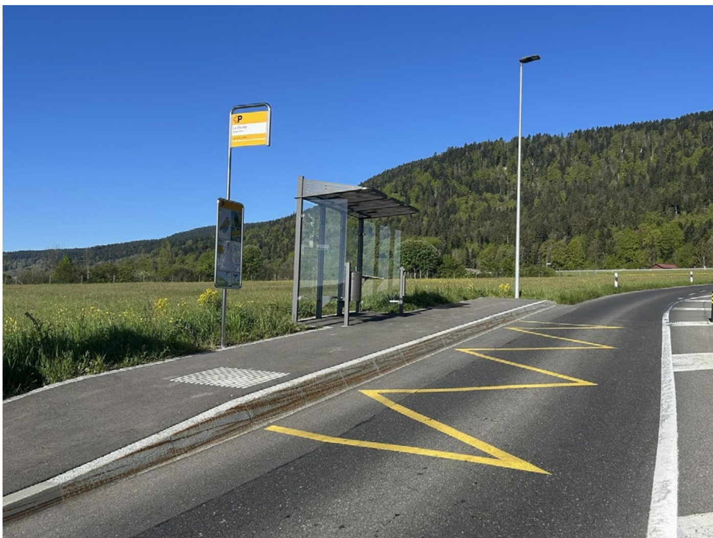
Bordo di fermata degli autobus conforme alla LDis in zona rurale (fermata AutoPostale La Chotte, © Comune Val-de-Ruz)
