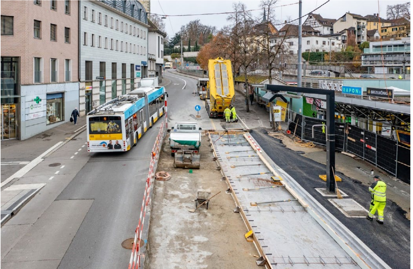
Construction d'une bordure d'arrêt de bus conforme à la LHand sur la place de la gare de Schaffhouse (© michael.schmid.photo, ville de Schaffhouse)
