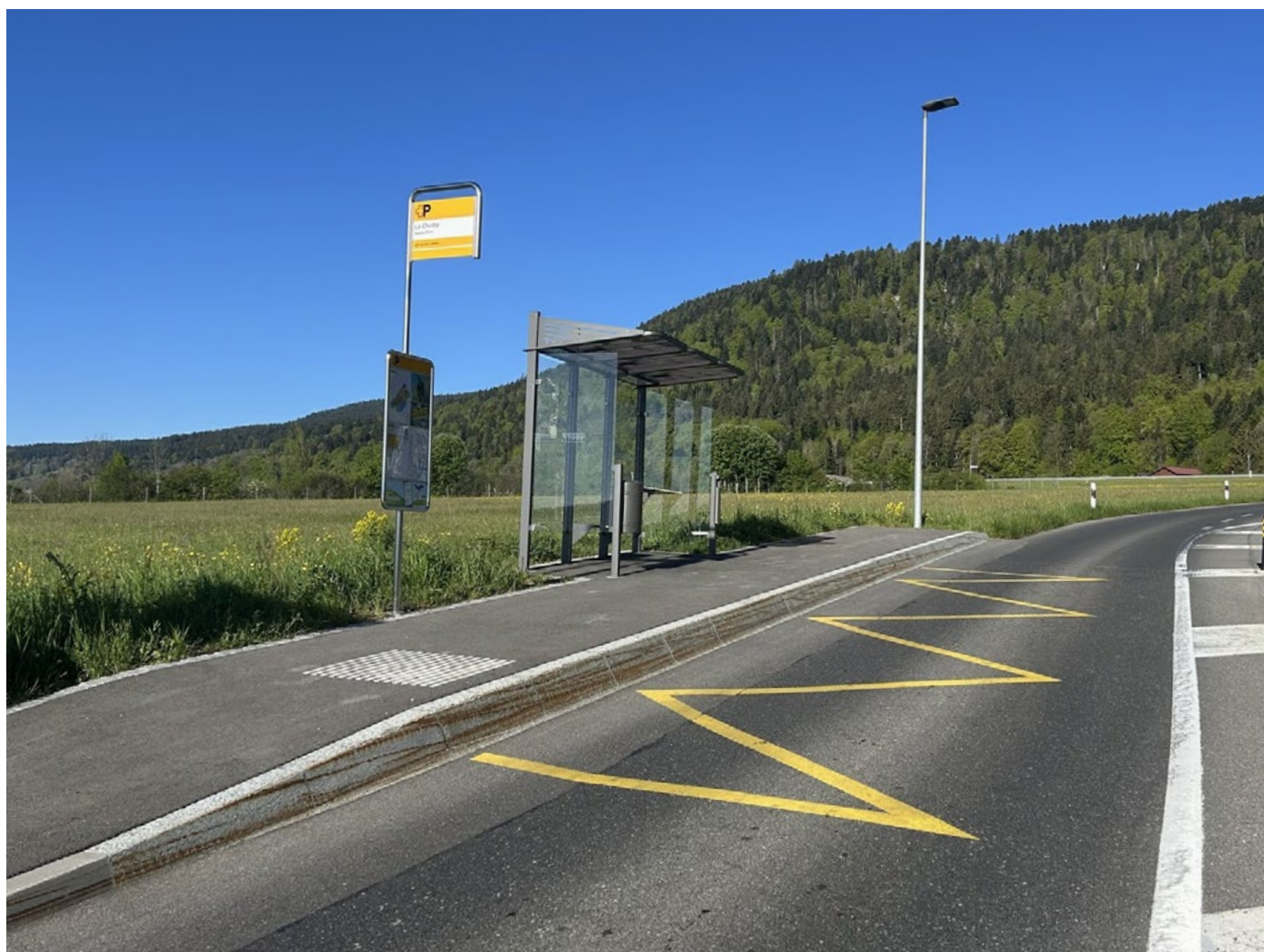
Bordure d'arrêt de bus conforme à la LHand en zone rurale (arrêt CarPostal La Chotte, © Commune de Val-de-Ruz)
