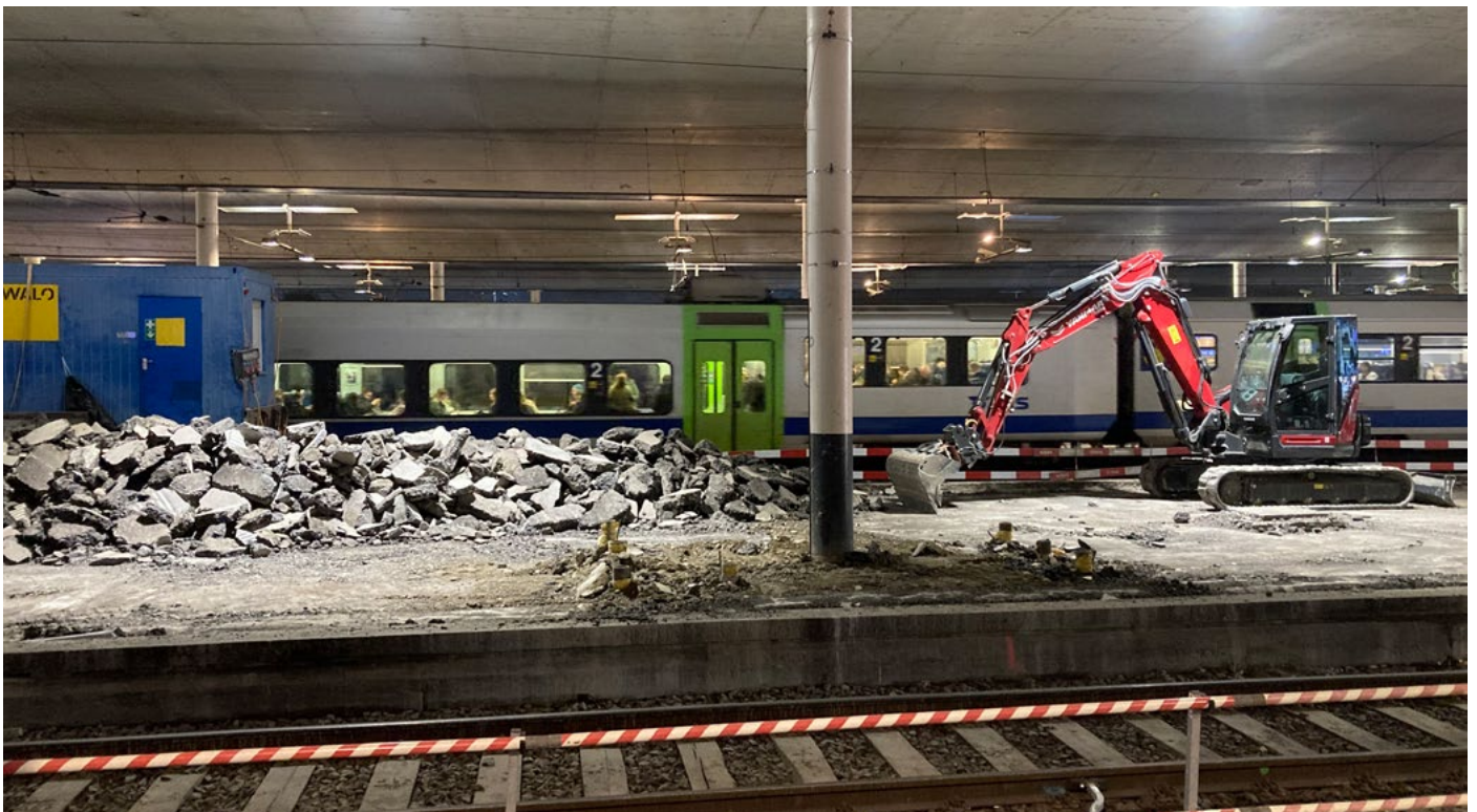
Les travaux de construction visant à mettre en œuvre les exigences de la LHand sont en cours dans de nombreux endroits. Ils sont souvent combinés avec d'autres travaux de construction. © OFT
