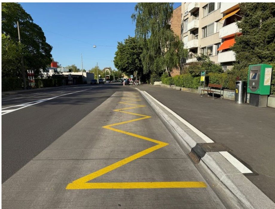
Bordure d'arrêt de bus conforme à la LHand en milieu urbain (© Adrienne Hungerbühler)
