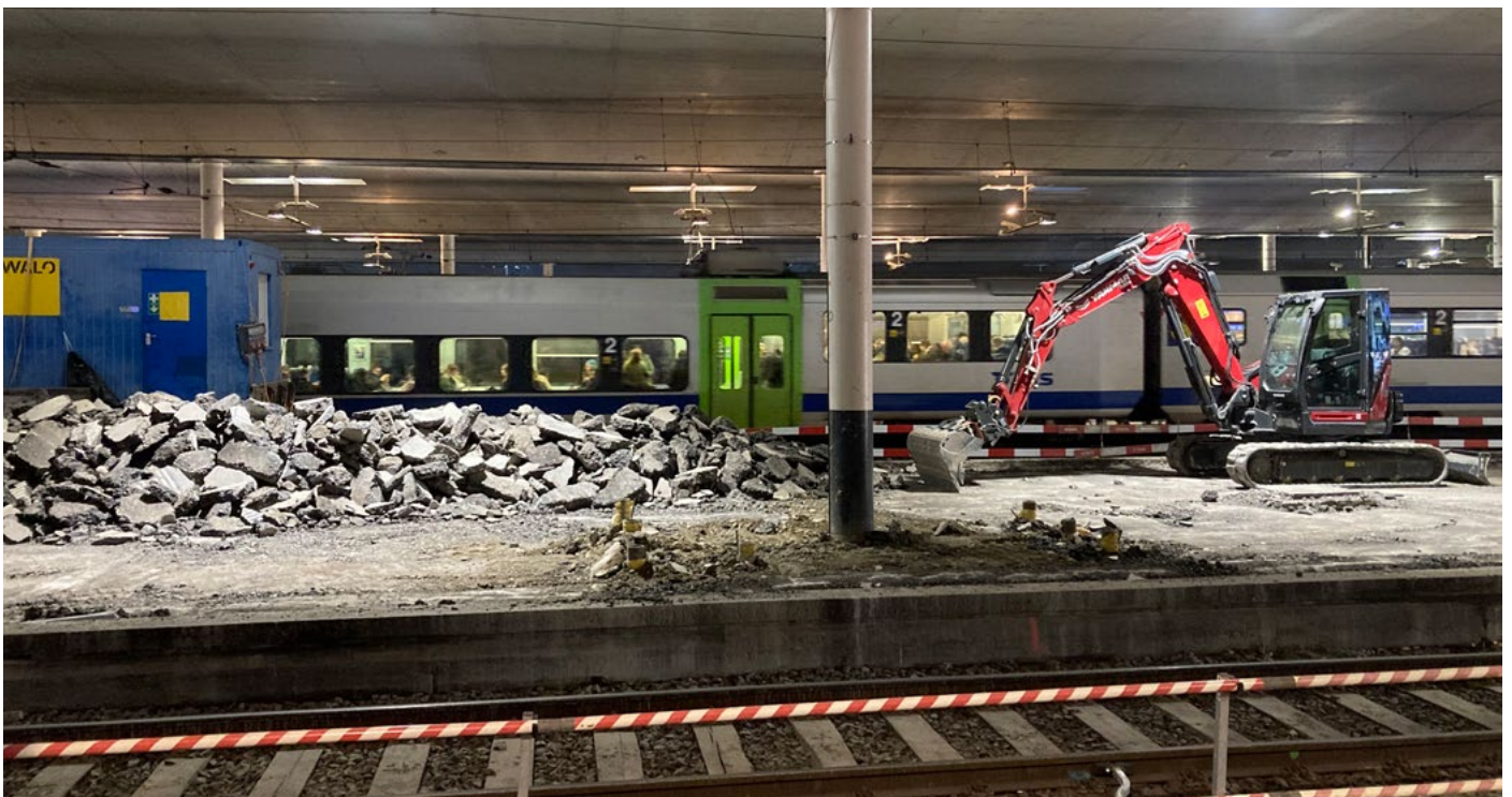
Die Bauarbeiten zur Umsetzung der Anforderungen des BehiG sind vielerorts im Gang. Oft werden sie mit anderen baulichen Massnahmen kombiniert.
