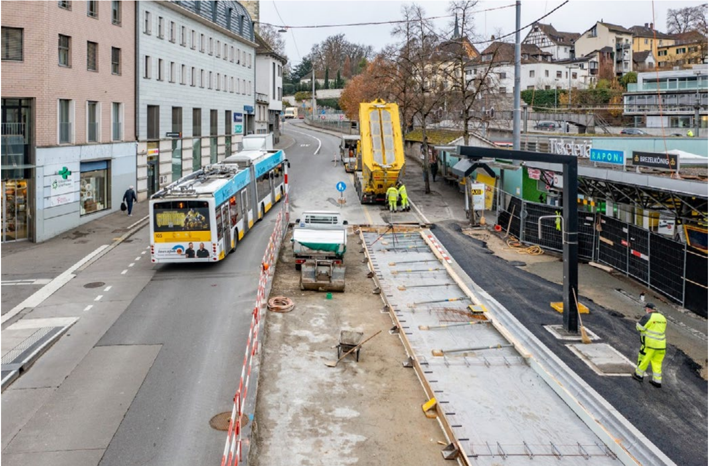
Bau einer BehiG-konformen Bushaltekante am Bahnhofplatz Schaffhausen (© michaelschmid.photo, Stadt Schaffhausen)
