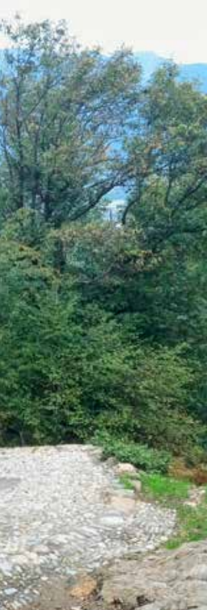
La Via storica del Montecenerino. Un progetto analogo sostenuto dal FSP è attualmente in fase di realizzazione nel Comune di Naters, nell'Alto Vallese, dove si sta risanando la vecchia strada che porta all'alpe Belalp, nella regione turistica dell'Aletsch. Foto: FSP
