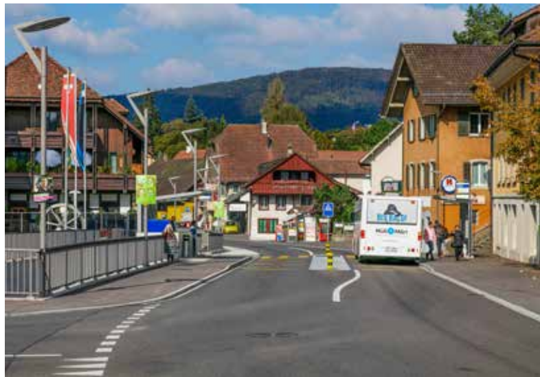
Il bus sosta sulla carreggiata e l'attraversamento pedonale è protetto da un'isola spartitraffico.
