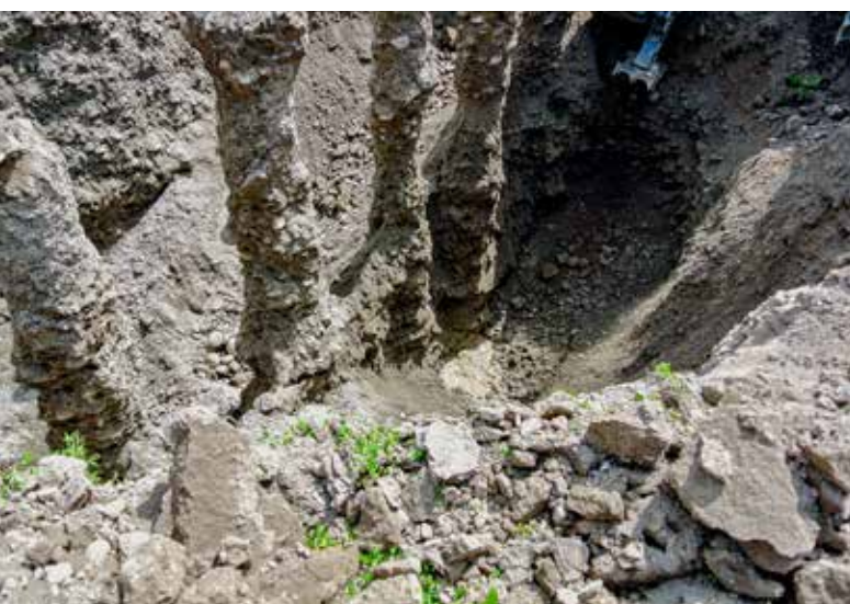
Fig. 3: Excavation des six pieux NDJ jusqu'en dessous du niveau des eaux souterraines. A droite: Evolution du pH (marge d'erreur: \pm 2\% ) pendant les dix heures suivant le forage; valeur indicative de 8,2 selon les critères du Département fédéral de l'intérieur (DFI), Berne (OPBD, 2016, état en 2018).
