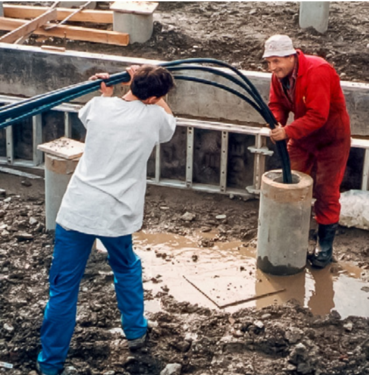
Des tubes en plastique sont insérés dans les fondations durant la construction, puis noyés dans le béton: un aperçu du chantier à Fully. Photo: mäd.
