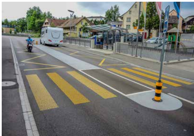
Le bus s'arrête sur la chaussée et les piétons traversent en sécurité grâce à l'îlot central.
