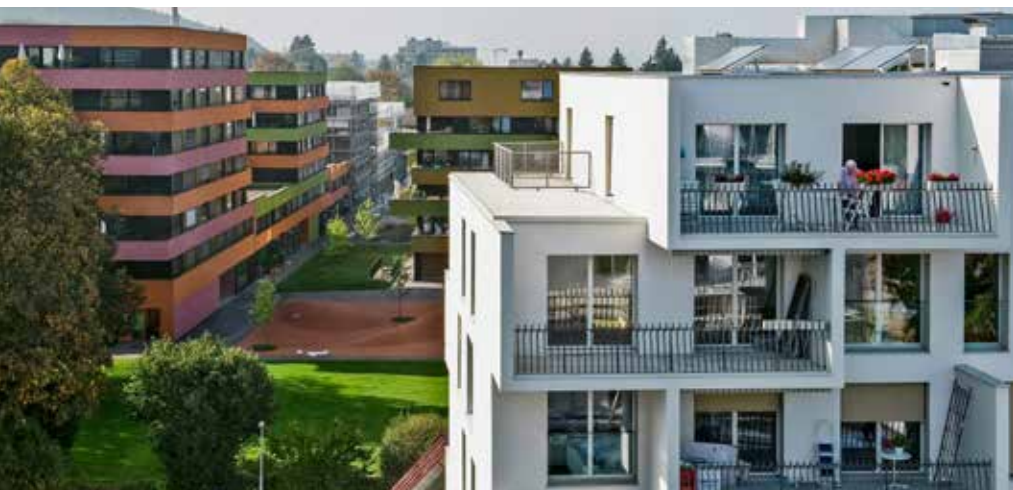
Dans ses nouveaux bâtiments, le lotissement Frieden à Zurich Affoltern propose notamment des appartements de 2,5 pièces.
