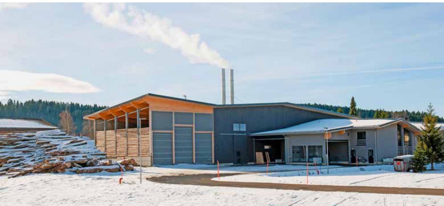
Vue d'ensemble du site de chauffage à distance et de la fromagerie.
