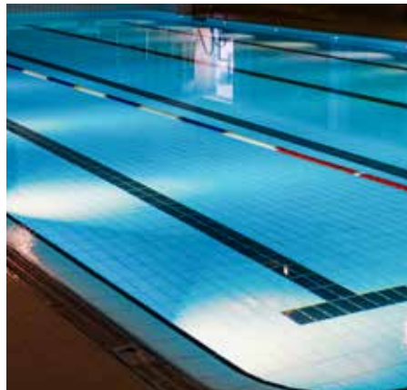
Die korrekte Temperatureinstellung der Wasseraufbereitung von Freizeitanlagen hilft, Legionellose vorzubeugen. Bild: Pixabay
