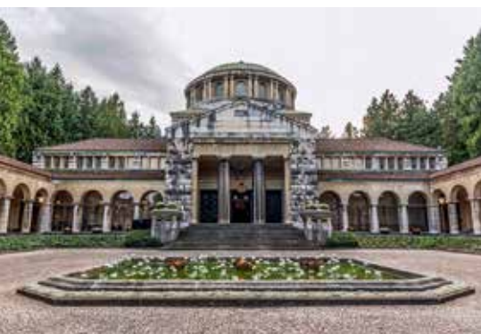
Aussensicht auf die Abdankungshalle des Krematoriums Sihlfeld in Zürich. Bild: zvg.
