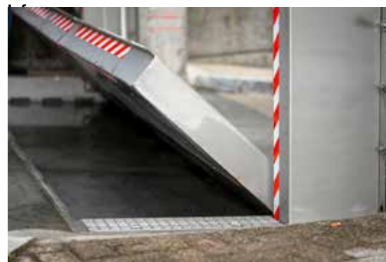
Ein automatischer Klappschott schützt Zugänge vor Hochwasser.
