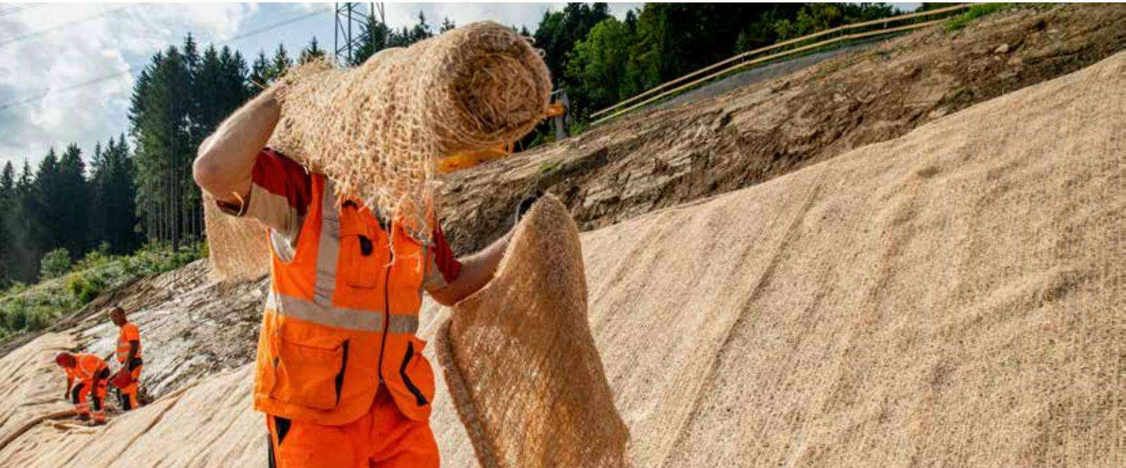
Das Risiko für Hangrutschungen ist besonders an neu erstellten Böschungen gross. Den besten Schutz gegen die Bodenerosion bildet eine stabile Vegetation mit einem starken Wurzelwerk. Zur Unterstützung werden Netze aufgelegt. Bild: Lindner Suisse
