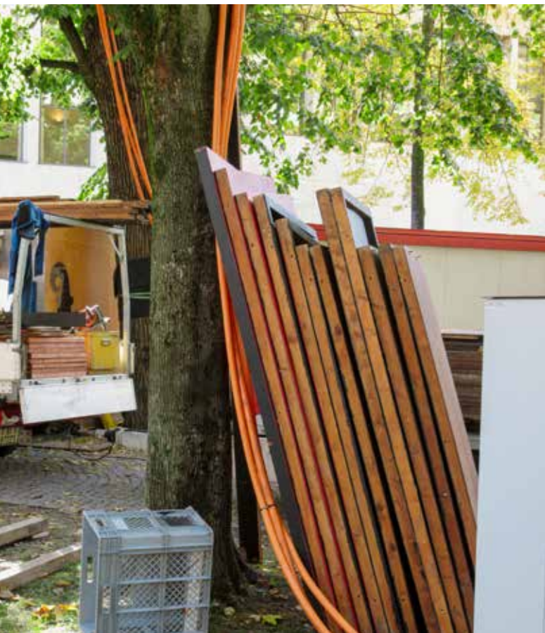
Mit dem Frühling kommt auch wieder die Zeit der Freiluftevents. Doch Bäume können grossen Schaden nehmen, wenn sie, wie auf dem linken Bild, nicht geschützt werden. Mit dem von der Stadtgärtnerei Basel entwickelten Modell lassen sich Baumstämme unterschiedlichen Durchmessers bei Bedarf bis zum Kronenansatz schützen.
