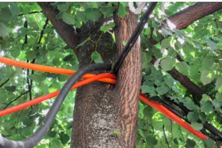
Um zu verhindern, dass Leitungen und Seile beim Verlegen in Baumkronen über Äste gezogen werden und dadurch Schäden verursachen (Bild links), müssen sie mit sogenannten Baumschlingen (Bild rechts) befestigt werden.
