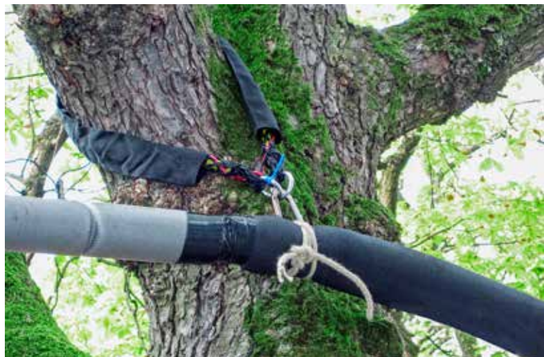
Um zu verhindern, dass Leitungen und Seile beim Verlegen in Baumkronen über Äste gezogen werden und dadurch Schäden verursachen (Bild links), müssen sie mit sogenannten Baumschlingen (Bild rechts) befestigt werden.
