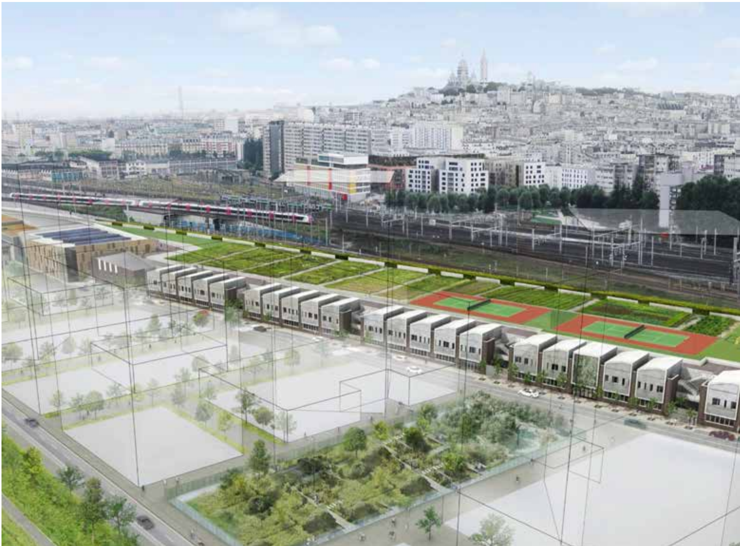
Zeichnung des «hôtel logistique» am Fusse des Montmartre in Paris. Der 400 Meter lange Bau, der unter anderem einen Umladeterminal beherbergt, verfügt über ein begrüntes Dach mit Sportflächen und «urbaner Landwirtschaft».
