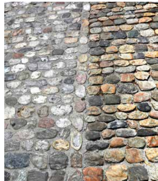
Das berühmte Wackepflaster der Stadt Basel schüttelt Velofahrer durch, Rollstuhlfahrer aber noch viel mehr. Auf dem Münsterhügel ist auf einem vier Meter breiten Weg das Pflaster abgeschliffen worden, um den Fahrkomfort zu erhöhen (vgl. Bild oben rechts). Bilder: Lucas Huber
