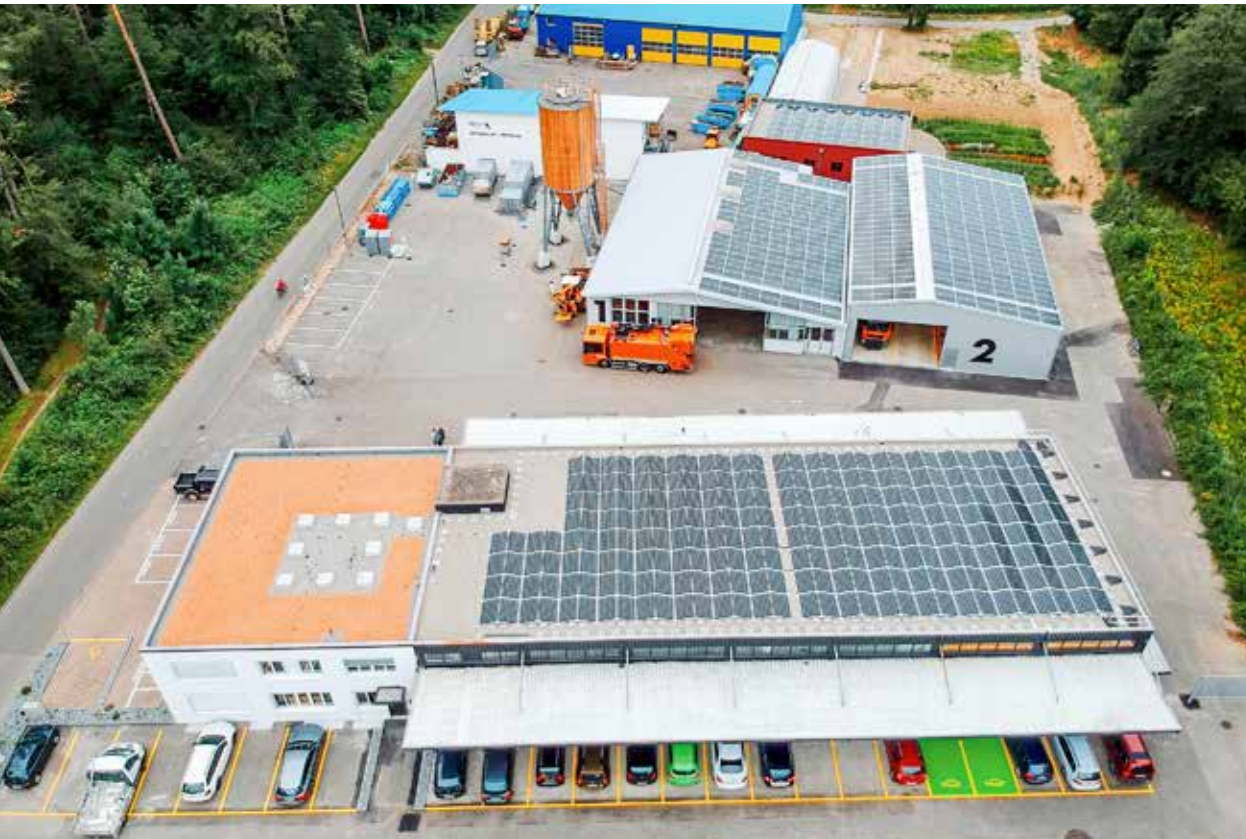
Die 217-kW-PV-Anlagen des Werkhofs sind auf vier Dächern verteilt und erzeugen jährlich 210 000 kWh Solarstrom.
