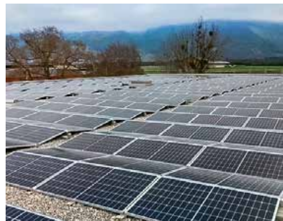
Landquart, Sporthalle Ried: Auf und an allen öffentlichen Gebäuden soll Energie produziert werden. Bild: zvg.
