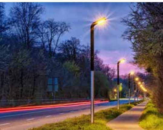
Fünf Jahre lang wurden verschiedene Solarleuchten für die Hardwald-Strecke getestet und diese schliesslich mit dem Modell «Mira» ausgerüstet. Die Akkus sind im Fussteil des Kandelabers platziert. Bild: Daniel Fosco
