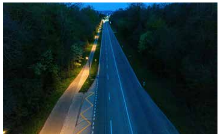
Auch der Veloweg neben der Hauptstrasse durch den Hardwald kann dank den autonomen Solarleuchten nachts sicher und komfortabel befahren werden.
