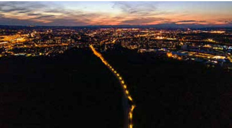
Die Strecke zwischen Birsfelden und Schweizerhalle in der Region Basel führt auf rund zwei Kilometern durch den Hardwald. Dank autonomen Solarleuchten kann sie beleuchtet werden. Die Verlegung einer Stromleitung war nicht nötig.
