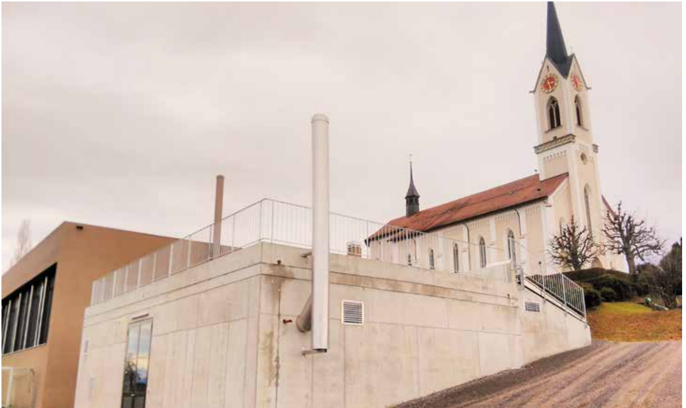
Aussenansicht der neuen Heizzentrale in Nottwil.
