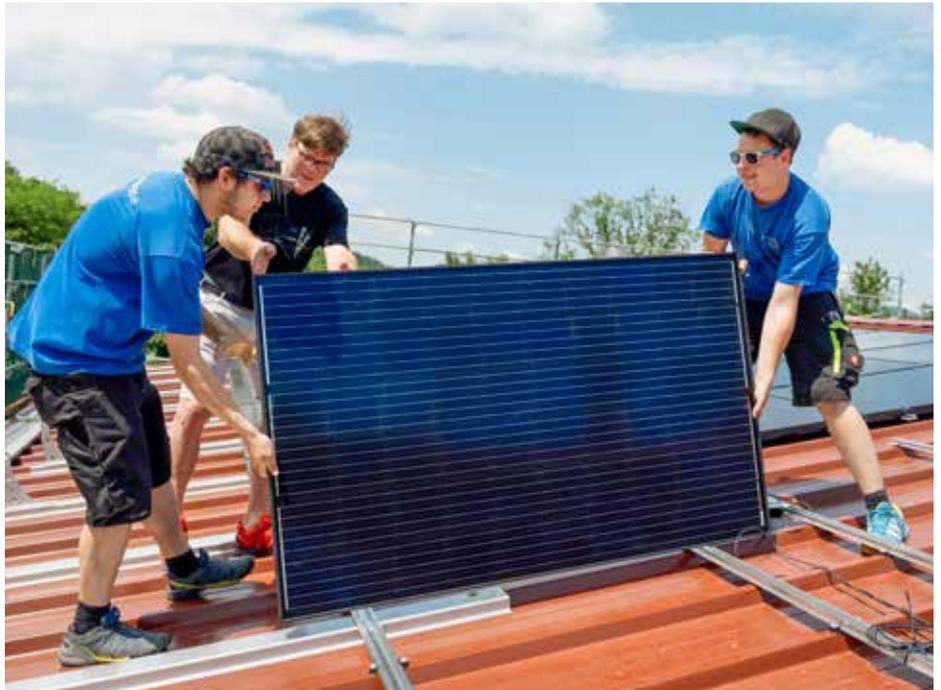
Das Dach des Werkhofs wird mit rund 190 m<sup>2</sup> Photovoltaikzellen mit einer Leistung von 33,5 kWp. Der Präsident von SpiezSolar packt mit an.
