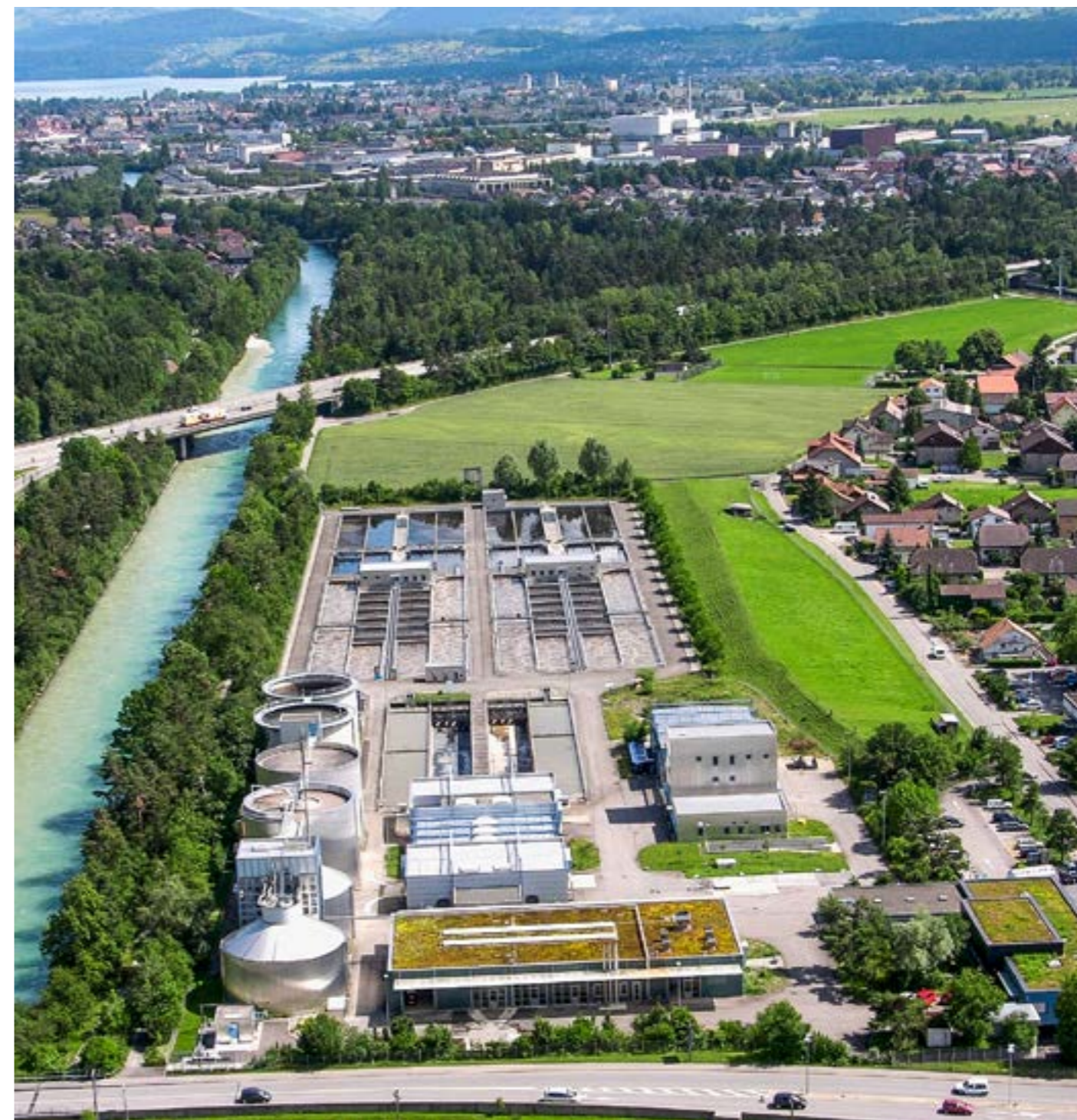
Ab Oktober soll die ARA Thunersee eine neue Anlage zur Gasaufbereitung in Betrieb nehmen.
