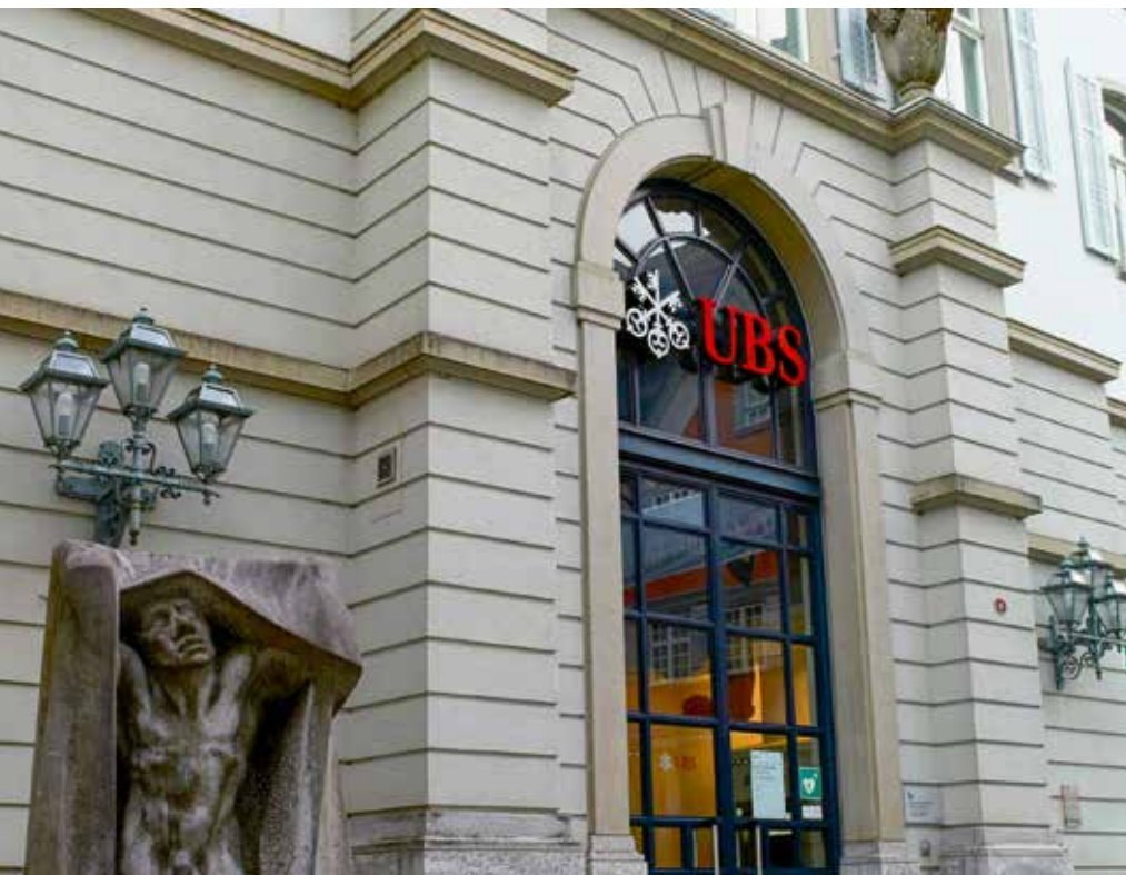
Das Bankgebäude ist heute schon barrierefrei. Für den Einzug der Gemeindeverwaltung sind nur kleine Anpassungen nötig.
