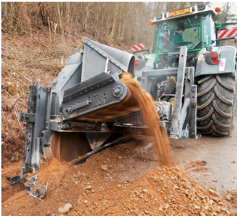
Lucas Huber Weit schneller als mit dem Bagger zieht die Fräse einen präzisen Graben.
