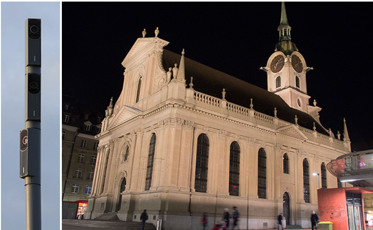
Figure 23 : Treize projecteurs montés en sept points sur des toits voisins ou sur les poteaux de l'éclairage public (photo de gauche) éclairent l'église du Saint-Espirit devant la gare de Berne (photo de droite ; source : Energie Wasser Bern). Dans les projecteurs, des masques créés sur mesure guident précisément la lumière. Cela permet de produire des différences de clarté et de mettre en évidence des détails tels que la balustrade du toit décorée de vases et d'urnes sur le côté de l'église.
