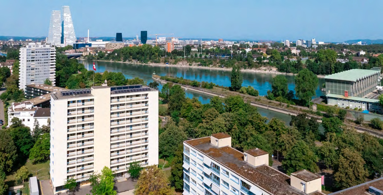
Le lotissement du Sternfeld appartient à la coopérative d'habitation des cheminots, qui y propose des logements abordables depuis les années 1960.
