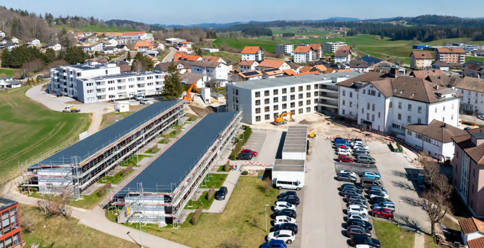
Die Wohngebäude von Les Marguerites bieten preisgünstige, hindernisfreie Wohnungen in der Nähe des Dorfzentrums und des Jura-Spitals.
