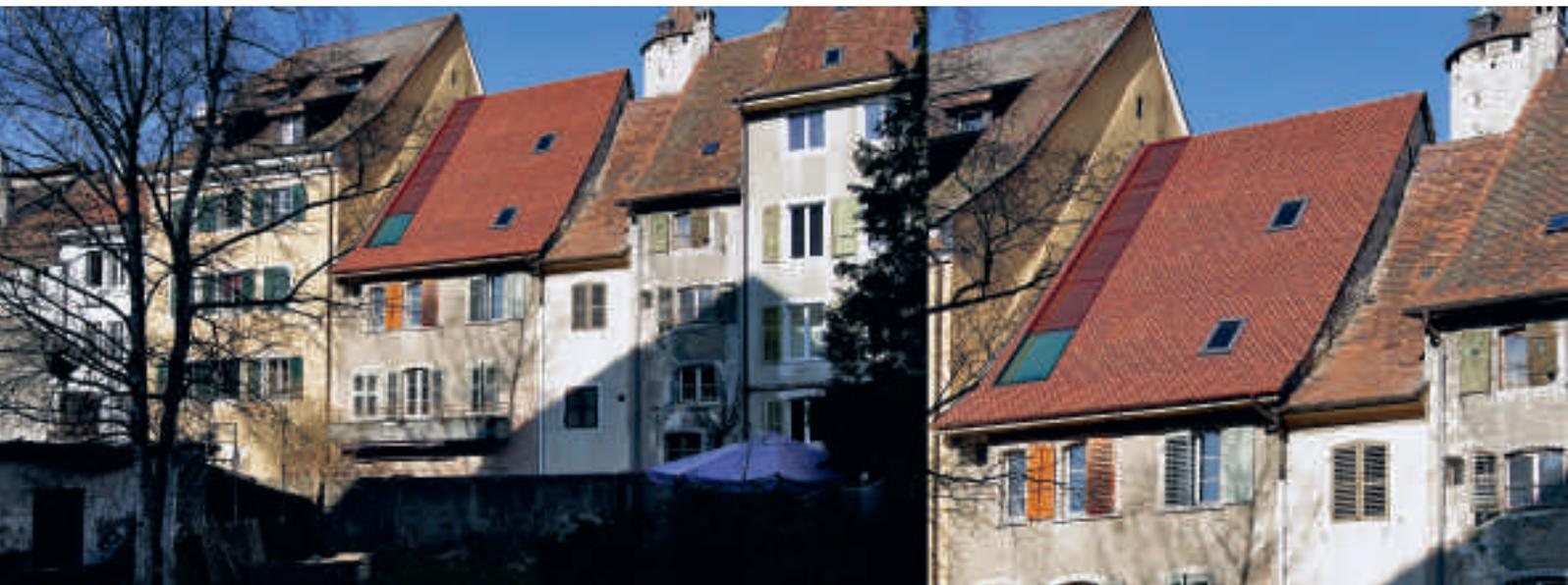
*An jeder Dachseite dieses Altbaus in Pruntrut wurde ein Lichtband angebracht, das für mehr Licht im Innern sorgt. Die Oberseite des Bandes besteht aus einem Metallgeflecht, das zur Dachfarbe passt.*
