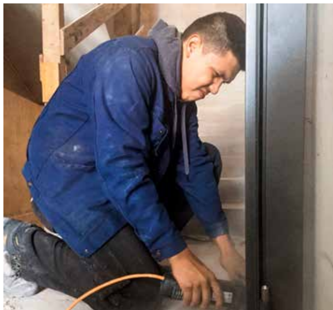
Actuellement, le jeune Equatorien travaille sur le chantier du Silo à Renens (VD). Photo: Denise Lachat
