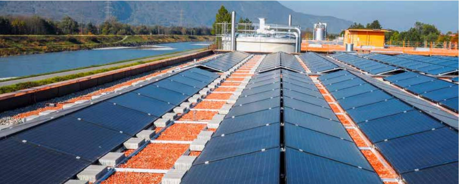
Die Photovoltaikanlage im Gewerbegebiet Gamprin mit einer Leistung von 354 kWp.
