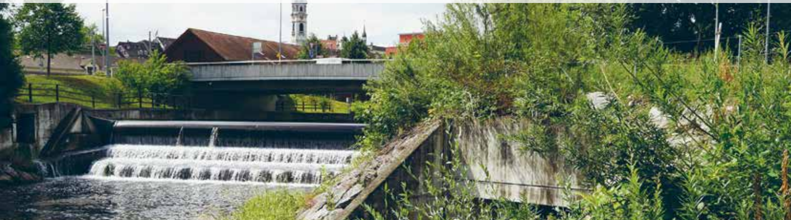
Das Kleinwasserkraftwerk «Zeughausbrücke» ist im Besitz der Werkbetriebe Frauenfeld und hat eine Leistung von 120 kW. Mit den jährlich produzierten 440'000 kWh können rund 100 Haushalte mit elektrischer Energie versorgt werden.
