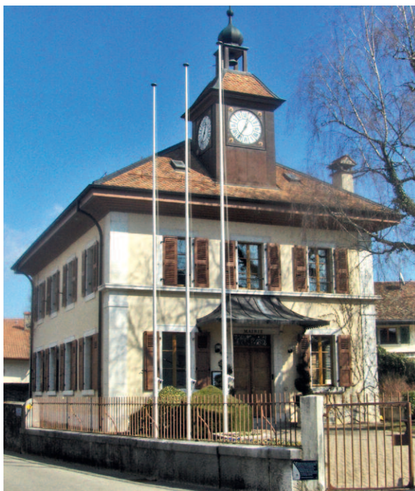
Faute de moyens, Avully a provisoirement renoncé à remplacer la chaudière à mazout de la mairie.
