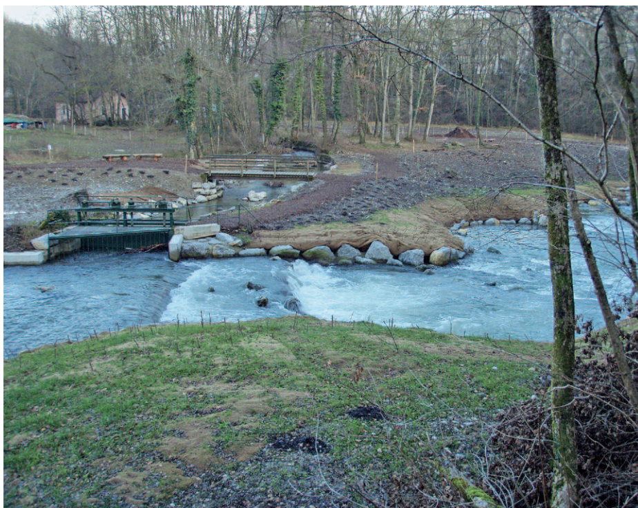
La Versoix revitalisée avec la prise d'eau du canal des Usiniers et les bassins qui permettent de récupérer la chute de trois mètres de hauteur de l'ancien barrage.
