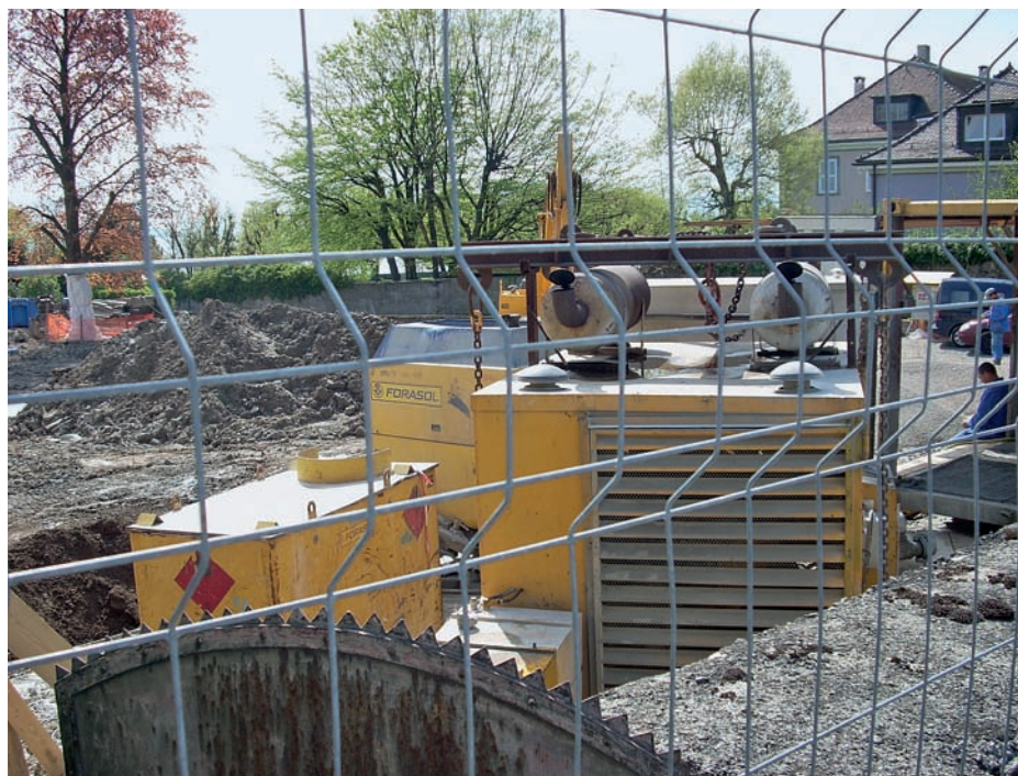
Derrière un réseau de fer à béton un groupe électrogène qui doit poser quelques problèmes à déplacer. Or cette machine va «tourner» longtemps et pas si loin des fenêtres du voisin. (Photos: Bureau d'ingénieurs Monay et Associés SA)
