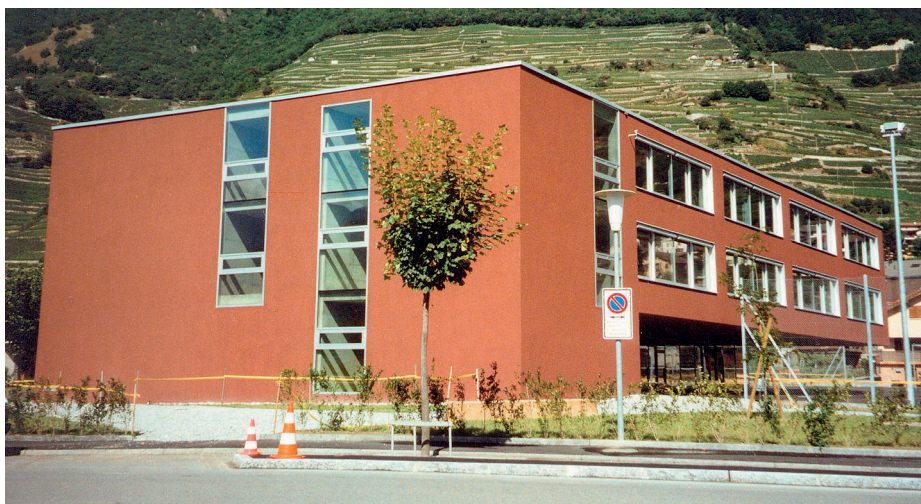
Bâtiment scolaire Minergie chauffé et refroidi par des pieux énergétiques à Fully. (Photo: E. de Lainsecq)
