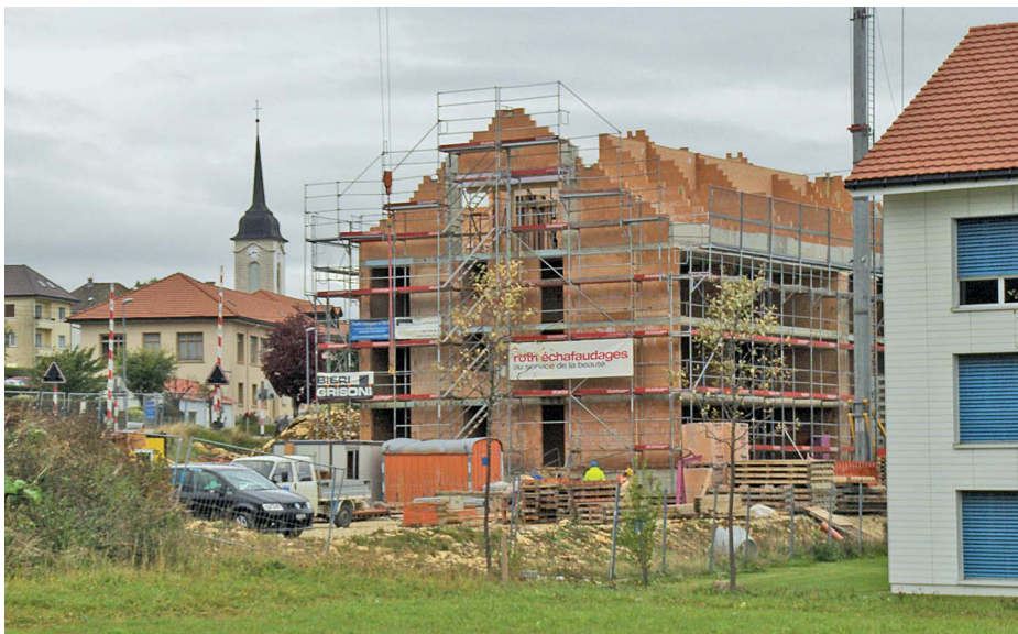
Le chantier du premier locatif, à quelques pas du centre du village des Breuleux. (Photos: Vincent Borcard)
