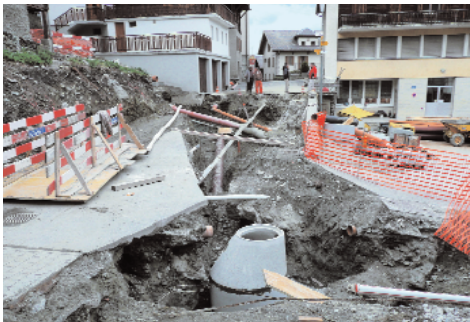
Au cœur d'Hérémence: toute modification du réseau souterrain entraîne des répercussions lourdes sur les voies de liaison en surface. (Photos: CREM)
