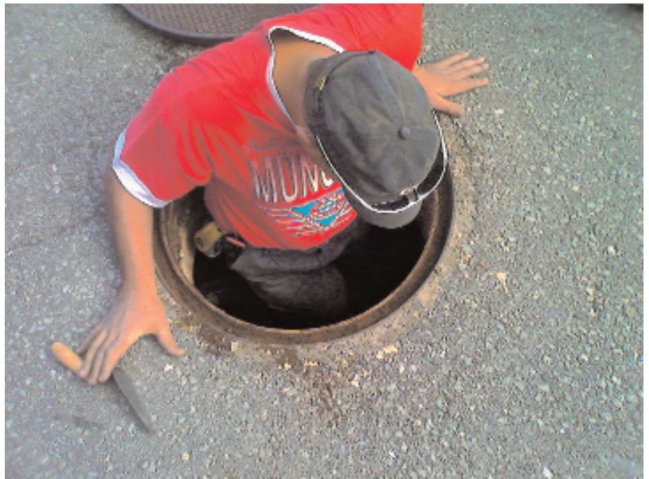
Le fontainier s'apprête à entrer dans les entrailles du réseau pour y entreprendre une réparation. (Photos: CREM)
