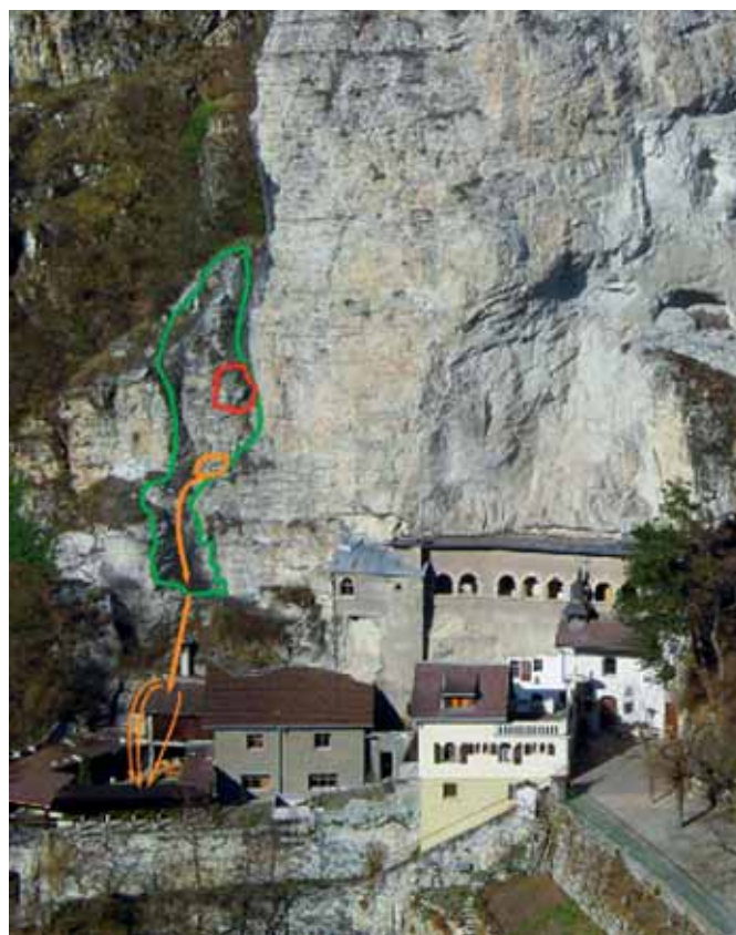
Écroulement d'un pan rocheux (orange) sur les bâtiments de l'ermitage de Longeborgne en décembre 2004.
