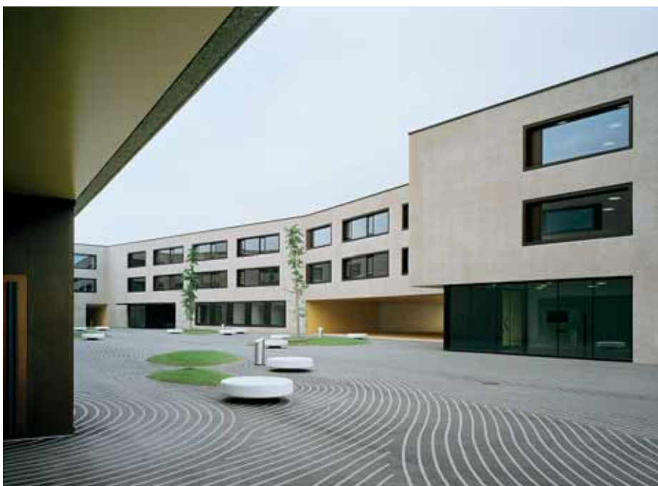
Le gymnase intercantonal de la Broye témoigne une intégration architecturale réussie des valeurs de Minergie. (Photo: Georg Aerni, Zurich)
