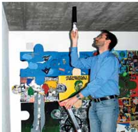
Dans les couloirs, 178 ampoules de 40 W ont été remplacé par des lampes économies d'énergie.
