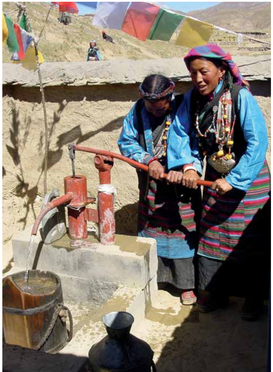
Construire un puits et le doter d'une pompe, c'est s'assurer de l'eau potable en suffisance, améliorer l'hygiène et s'éviter de longues marches jusqu'au point d'eau.
