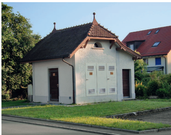
Eine von 14 Trafostationen in der Zürcher Gemeinde Wiesendangen, die ihr Elektrizitätswerk verkauft hat.
