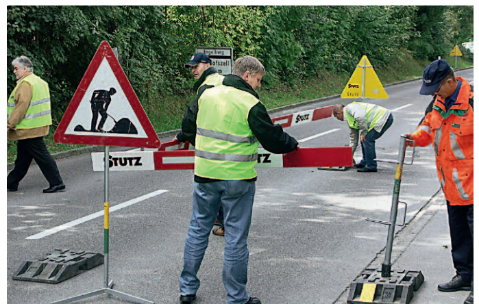
Die Arbeitssicherheit ist ein Schwerpunkt der breiten Themenpalette, die am Strassenmeisterkurs behandelt wird. (Bild: Kommunale Infrastruktur)
