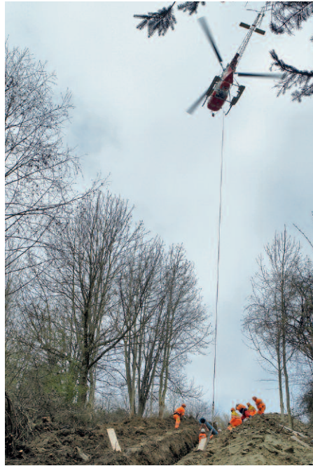
Leitungsbau ist aufwendig, deshalb ist es umso wichtiger, die Arbeiten zu koordinieren.
