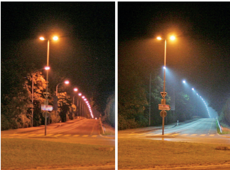
Die mit 30 LED-Leuchten vermutlich längste LED-Teststrecke der Schweiz, die Geissbühlstrasse in St. Gallen, vor (links) und nach der Umrüstung. (Bilder: zvg)
