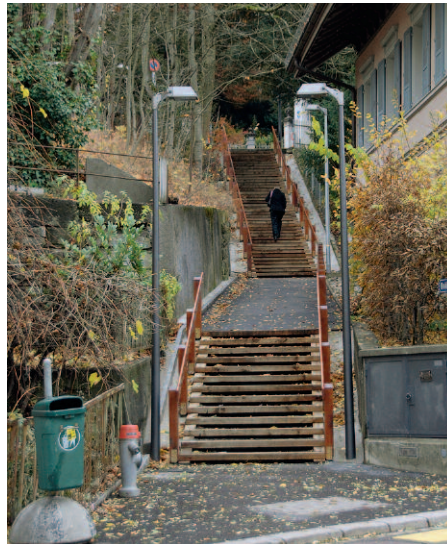
LED soll in St. Gallen helfen, die Fussgängerwege als öffentlichen Raum zu markieren. (Bild: Brigitte Traber)
