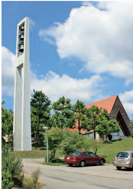
Die 1959 erbaute Markuskirche der evangelisch-reformierten Kirchgemeinde Grenchen-Bettlach.
